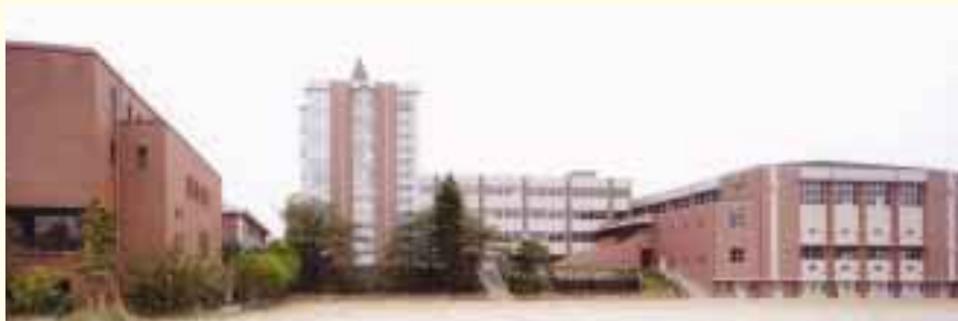
北側から望む、校舎全景。
